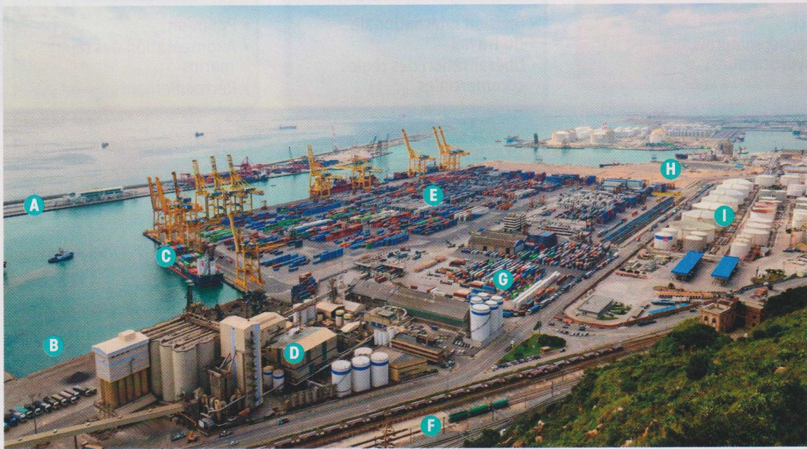
Photographie aérienne du port industriel de Barcelone, 2013.
